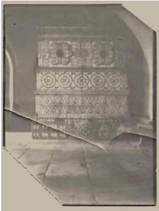
Рис. 13. Свионтковская Л. И. Фотография. Устюг. Церковь Петра и Павла. Великий Устюг, 1914 г. Архив А. В. Филиппова. Первая публикация Fig. 13. Ustyug. Peter and Paul Church. Photo by L. I. Sviontkovskaya. Veliky Ustyug, 1914. A. V. Filippov Archive. First publication
