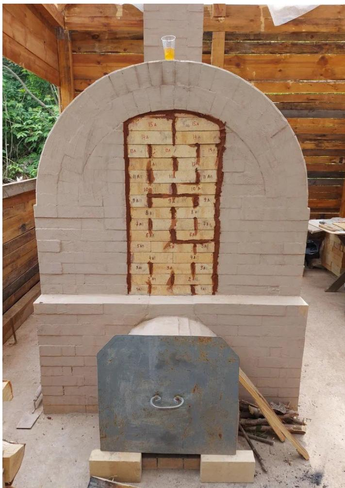
Рис. 16. Запечатывание камеры реконструированного горна на реке Щуке. Фото: В. А. Рыженок
