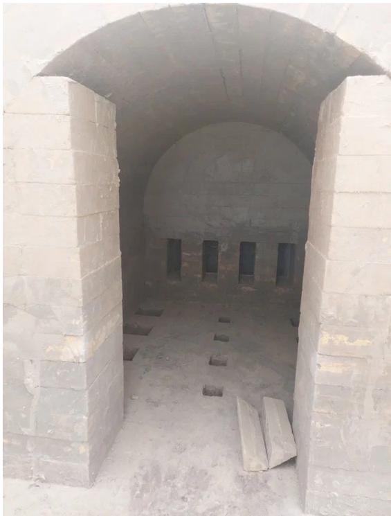
Рис. 13. Продухи в поде реконструированного горна. Фото В. А. Рыженок
