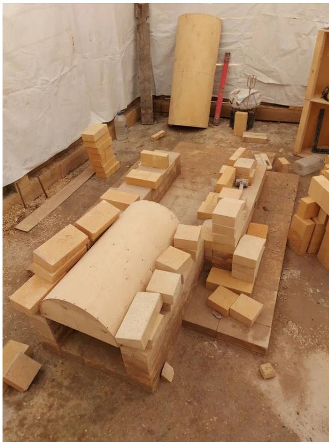
Рис. 11. Возведение устья топливной камеры. Фото В. А. Рыженок
