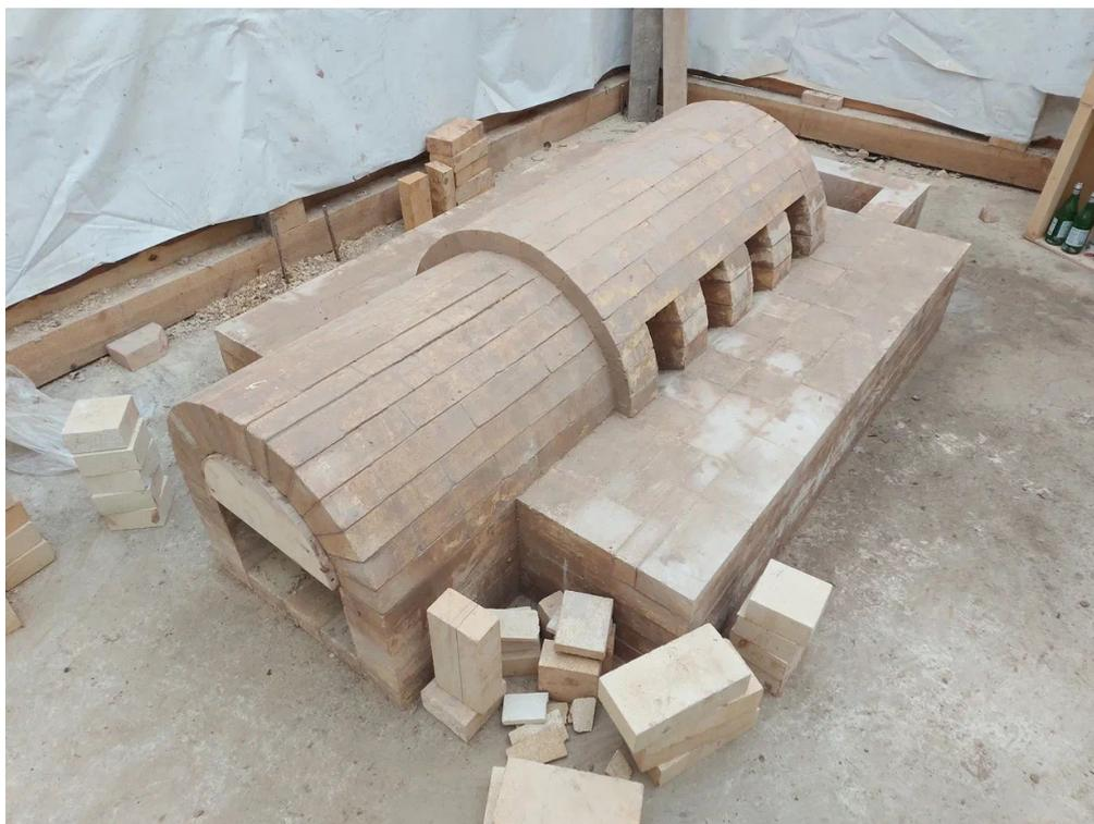
Рис. 9. Топливная камера горна. Фото В. А. Рыженок
