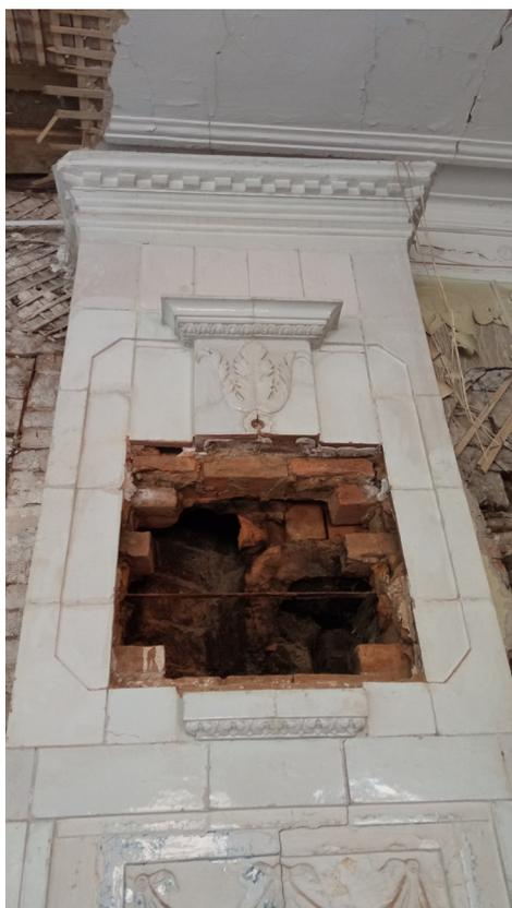
Рис. 9. Демонтаж центральной части камина в 2024 г.
