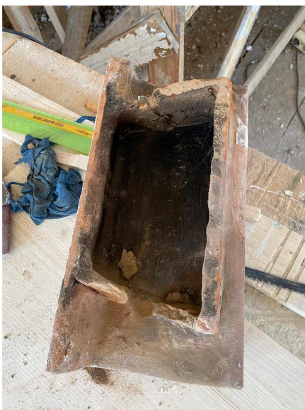
Рис. 10. Румпа демонтированного изразца центральной части камина. Старые сколы и проволочное крепление в отверстии румпы. 2024 г.
