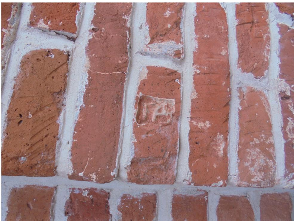
Рис. 4. Следы отесывания кирпичей в кладке Первого Кавалерского корпуса. Фото автора
