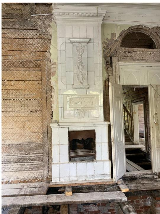
Рис. 8. Отсутствие фундамента изразцового камина на момент начала реставрационных работ в 2020 г.
