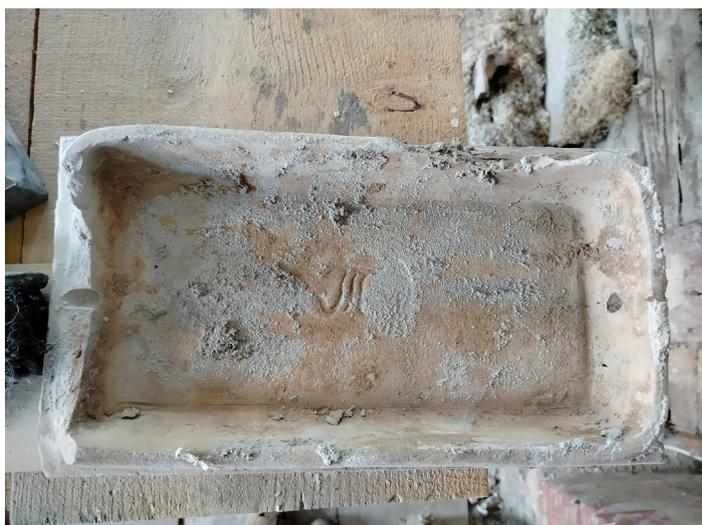
Рис. 13. Клеймо в виде буквенной маркировки на оборотной стороне изразца, демонтированного с нижней части камина в 2024 г.
