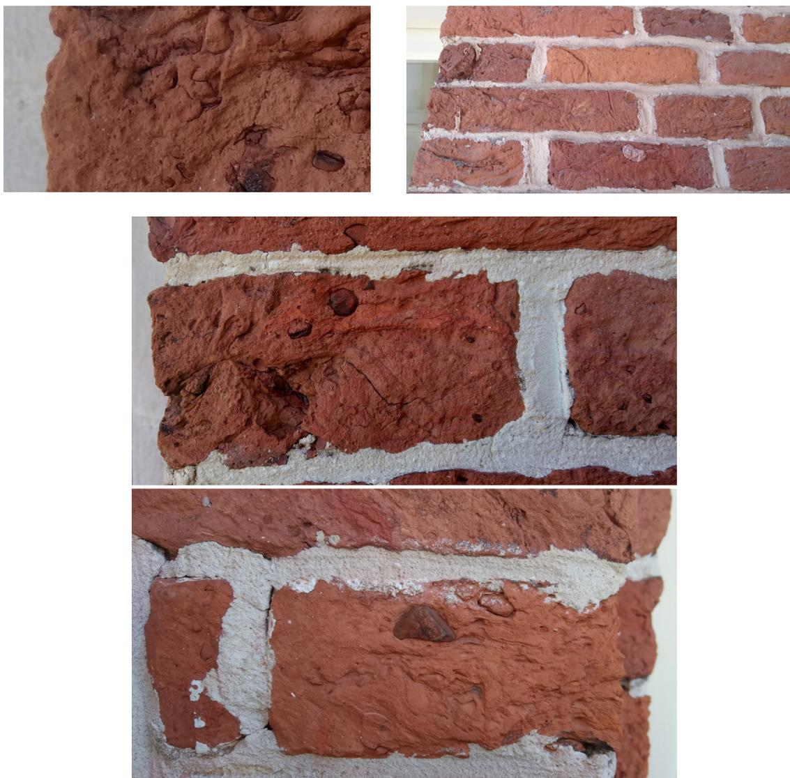
Рис. 7 а, б, в. Включение многочисленных камней и керамических черепков в кирпичную массу верхней кладки центральной части Большого дворца. Фото автора
