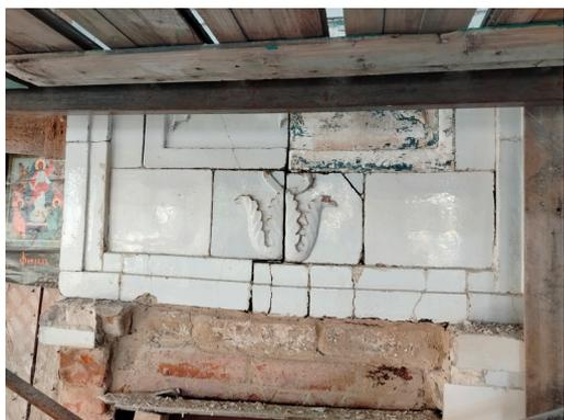
Рис. 15. Удаление красочного слоя на гирлянде и демонтаж поздней бетонной полки в 2024 г.
