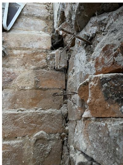
Рис. 14. Следы ремонтного монтажа изразцов в виде вбитого в кладку гвоздя с намотанной на него проволокой. 2024 г.
