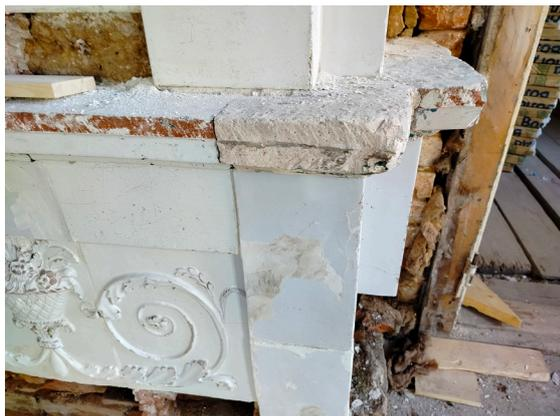
Рис. 18. Стесанный край изразцовой полки калориферной печи и ее угол, восполненный в процессе предыдущих реставраций
