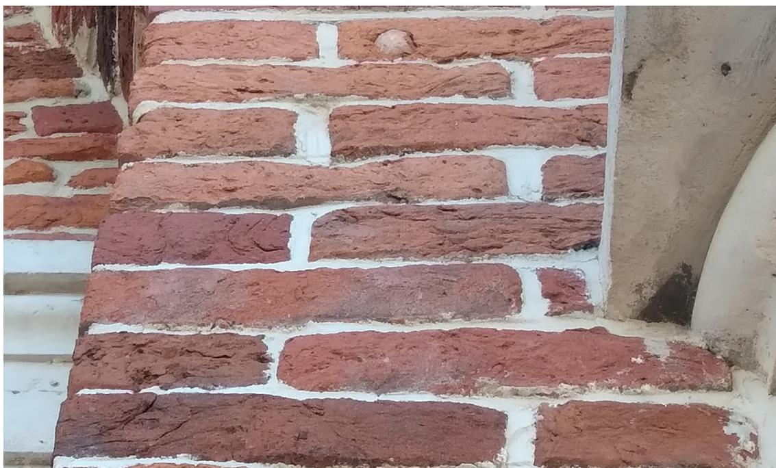
Рис. 6. Включение большого камня в кирпичную массу верхней кладки центральной части Большого дворца. Фото автора
