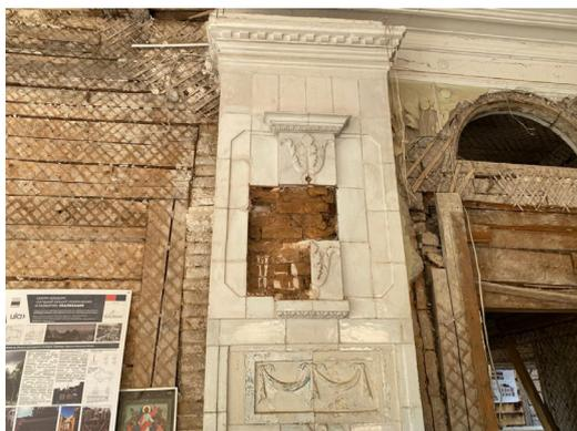
Рис. 11. Отличие изразцов верхнего ряда и карнизного завершения камина с основной изразцовой облицовкой
