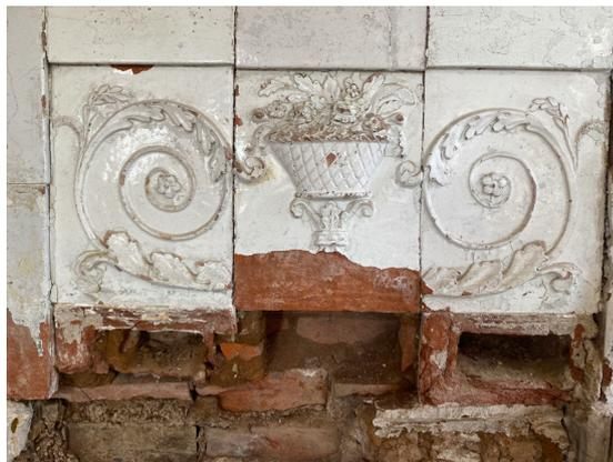
Рис. 19. Состояние изразцовой облицовки основания калориферной печи. 2023 г.
