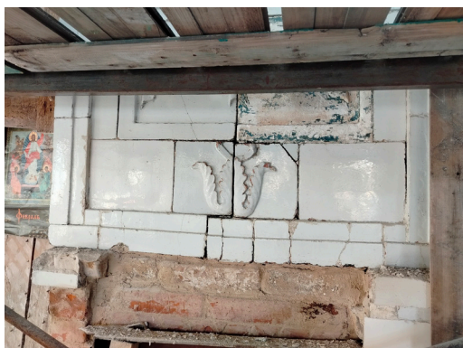
Рис. 15. Удаление красочного слоя на гирлянде и демонтаж поздней бетонной полки в 2024 г. Fig. 15. Removal of the paint layer on the garland and dismantling of the later concrete shelf in 2024
