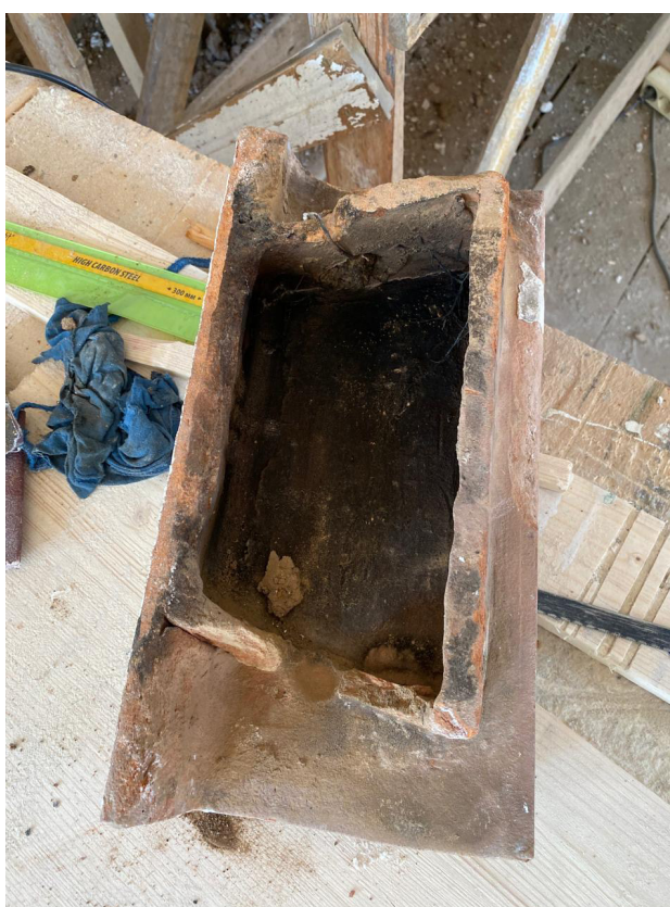
Рис. 10. Румпа демонтированного изразца центральной части камина. Старые сколы и проволочное крепление в отверстии румпы. 2024 г. Fig. 10. The back side (rumple) of a dismantled tile from the central part of the fireplace. Old chips and wire fastening in the rumple hole. 2024
