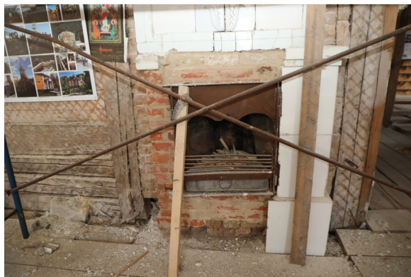
Рис. 12. Демонтаж облицовки нижней части камина в 2024 г. Фото предоставлено информационно-аналитическим центром «Культура в Вологодской области» Fig. 12. Dismantling the lower part of the fireplace cladding in 2024. Photo provided by the Information and Analytical Center "Culture" in the Vologda Region
