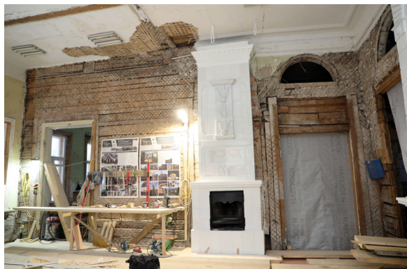
Рис. 16. Камин после реставрации. 2024 г. Фото предоставлено информационно-аналитическим центром «Культура в Вологодской области» Fig. 16. The fireplace after restoration. 2024. Photo provided by the Information and Analytical Center "Culture" in the Vologda Region
