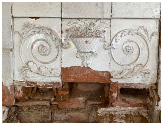
Рис. 19. Состояние изразцовой облицовки основания калориферной печи. 2023 г. Fig. 19. Condition of the tiled cladding at the base of the calorifer stove. 2023
