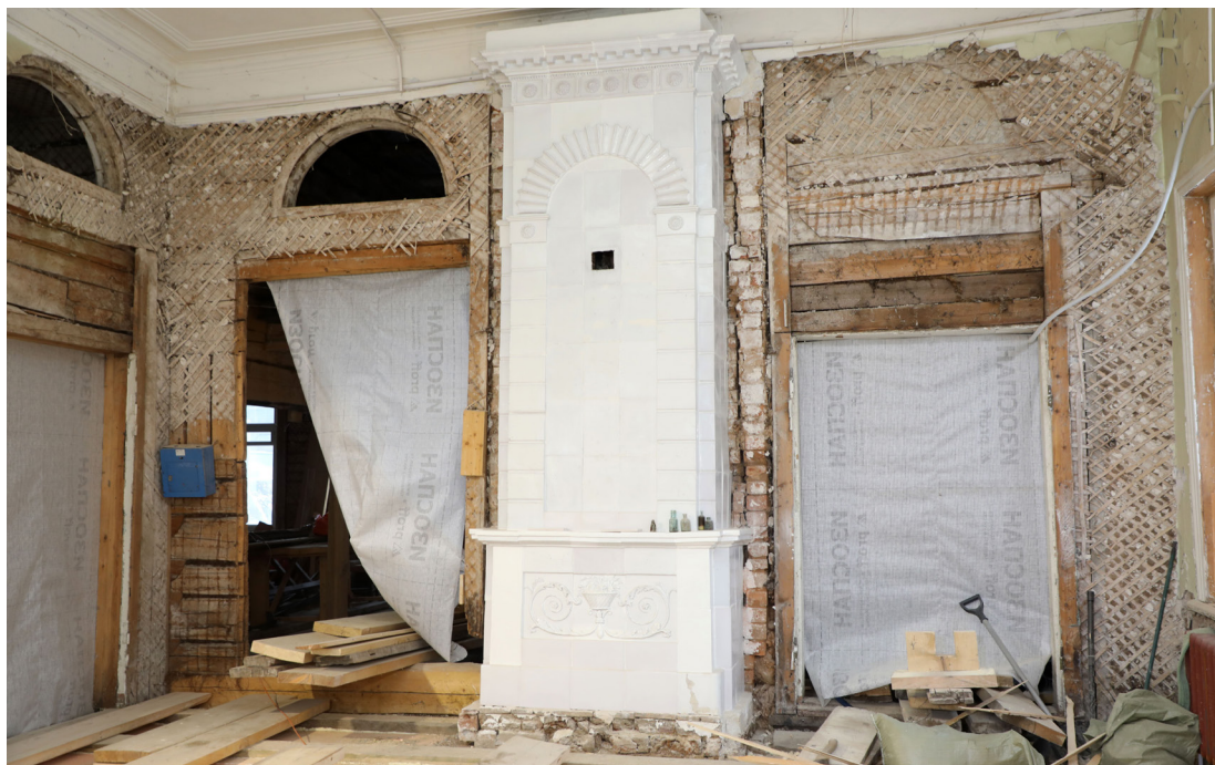
Рис. 20. Калориферная печь после реставрации. 2024 г. Fig. 20. The calorifer stove after restoration. 2024
