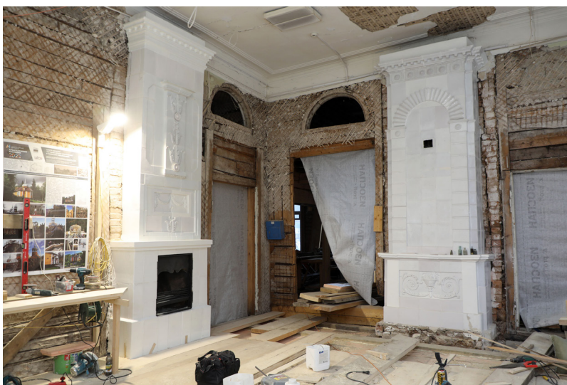
Рис. 2. Следы антресольного этажа в помещениях дома Засецких в виде арочных проемов в межкомнатных перекрытиях. Фото предоставлено информационно-аналитическим центром «Культура в Вологодской области»
