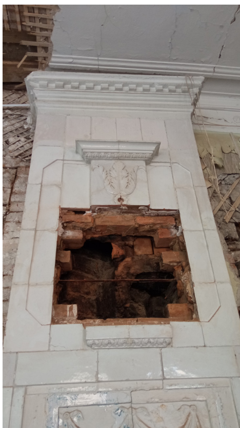
Рис. 9. Демонтаж центральной части камина в 2024 г. Fig. 9. Dismantling of the central part of the fireplace in 2024
