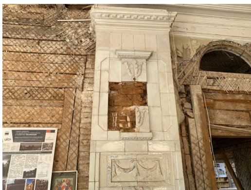
Рис. 11. Отличие изразцов верхнего ряда и карнизного завершения камина с основной изразцовой облицовкой Fig. 11. Differences between the tiles of the upper row and the cornice finish of the fireplace compared to the main tiled cladding
