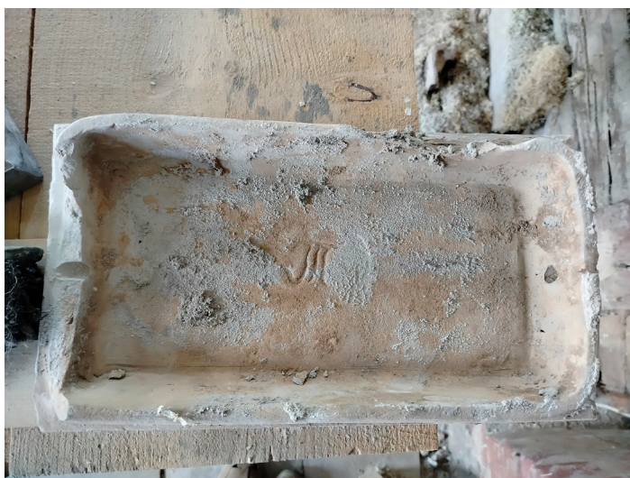
Рис. 13. Клеймо в виде буквенной маркировки на оборотной стороне изразца, демонтированного с нижней части камина в 2024 г. Fig. 13. A maker's mark in the form of letter markings on the reverse side of a tile removed from the lower part of the fireplace in 2024
