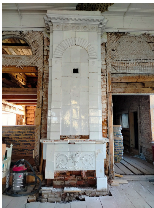
Рис. 17. Калориферная печь до реставрации
