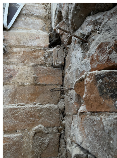
Рис. 14. Следы ремонтного монтажа изразцов в виде вбитого в кладку гвоздя с намотанной на него проволокой. 2024 г. Fig. 14. Traces of repair work on the tiles, including a nail driven into the masonry with wire wrapped around it. 2024
