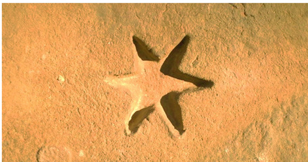
Рис. 16. Клеймо «подкова» (завод «Подкова» В. А. и Е. И. Спечинские, 1897–1917, С-Пб. губ.), клеймо «якорь» (завод «Якорь» А. В. и Т. В. Елисеевы, 1908–1917, С-Пб. губ.), клеймо «звезда» (Общество «Звезда для производства искусственных строительных материалов, 1896–1907, С-Пб. губ.)
