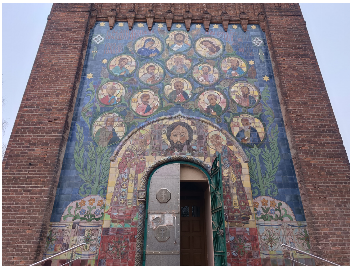
Рис. 17. Западный портал Воскресенского собора после окончания реставрационных работ. Фото «Паллада», 2024
