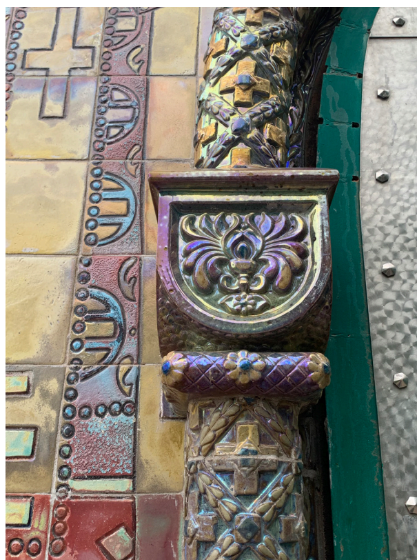
Рис. 14 а, б, в. Чертеж части декоративного архивольта над западным порталом, отформованная деталь архивольта и деталь в ансамбле портала. Фото «Паллада», 2023–2024
