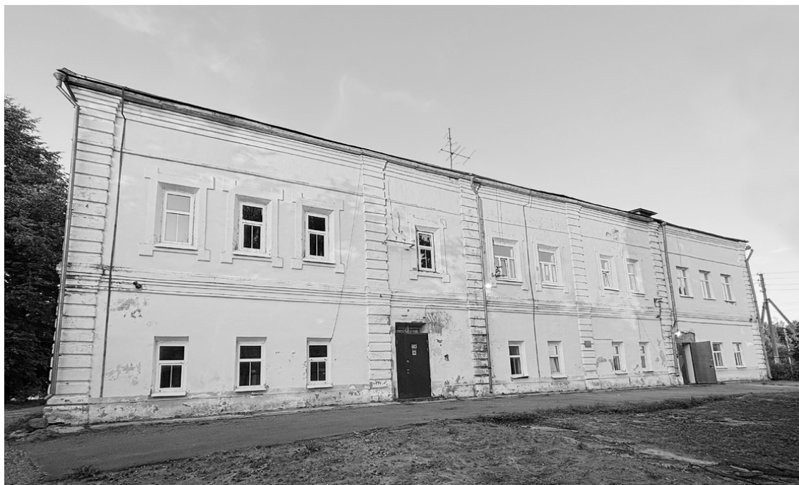
Рис. 1. Главный фасад дома усадьбы Рогозиных. Фото: Н. В. Савельевой, 2025 г.
